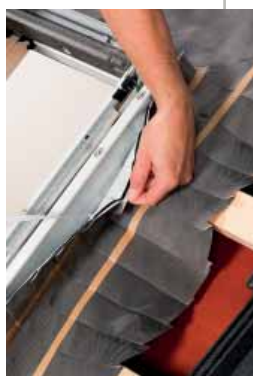
Alátétfólia vízelvezető csatornával
